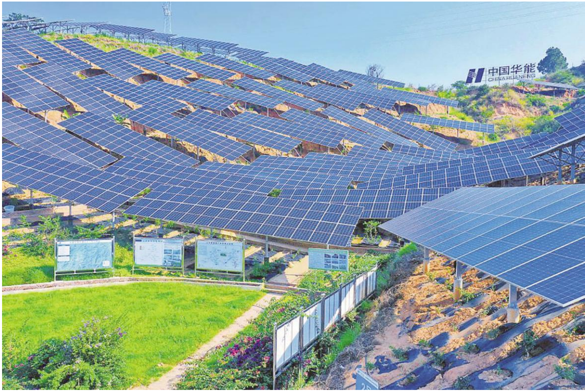
华能澜沧江大沙坝光伏项目。■ 王毅摄
