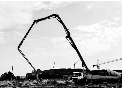
华景和顺 40 万千瓦/80 万千瓦时构网型储能项目建设现场。 ■ 综改区供图
