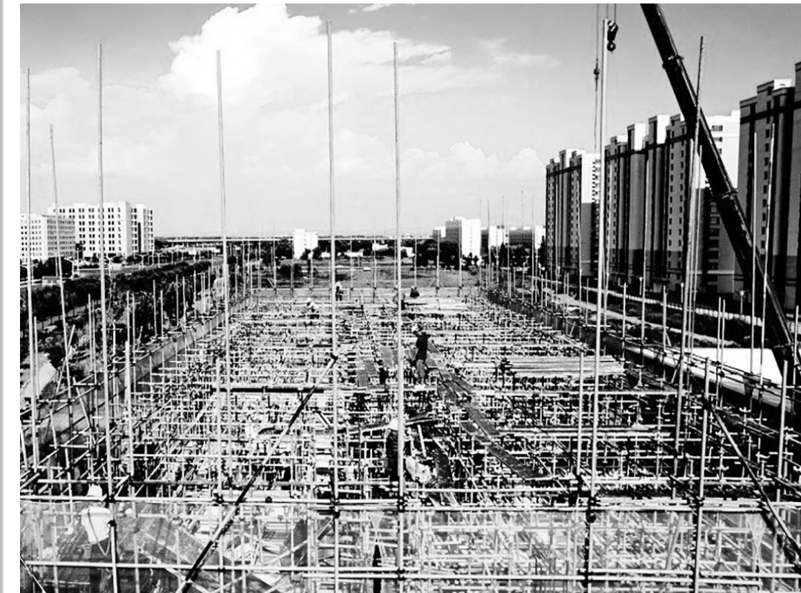
智能电网科技研发生产基地项目建设现场。 ■ 综改区供图
