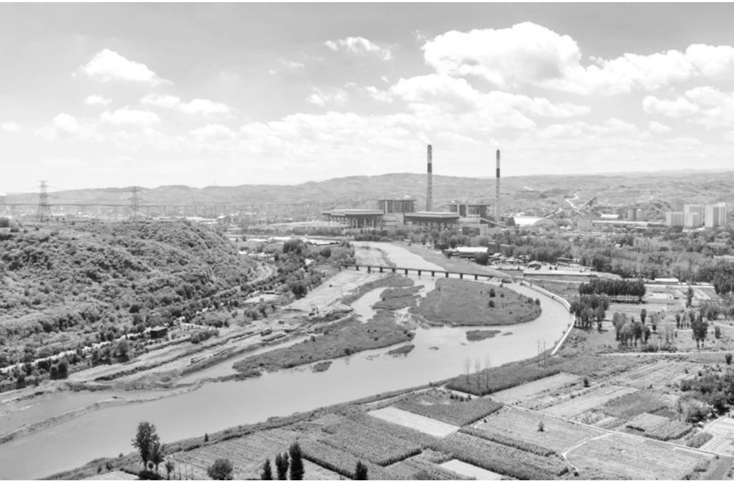
7月17日,霍州境内汾河河段景致清朗。依托“一泓清水入黄河”生态保护工程,当地实施河道清淤、污染管控、岸线绿化改造,对河道进行全面整治,沿河建成连续健身步道与景观绿化带,工程既筑牢流域生态屏障、提升防洪能力,也拓展市民休闲场所,实现生态治理与民生改善共赢。 ■ 田红萍摄
