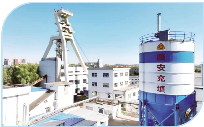
司马煤业公司地面充填站
