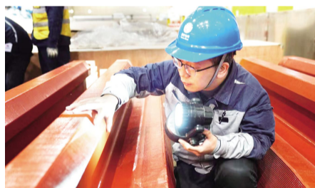
细致勘察电力设备
