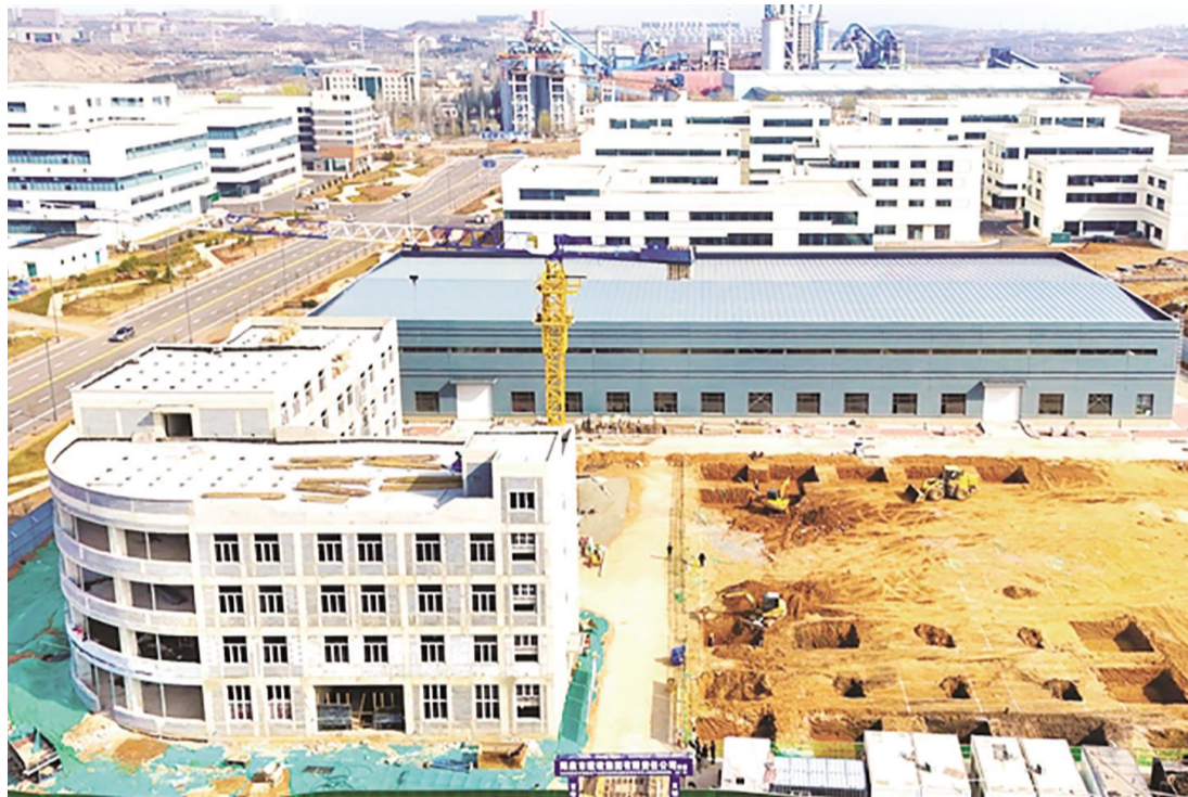
高新区智慧医药产业园及基础设施配套建设项目进入关键施工阶段，各楼栋建设工作有序推进。 ■ 张泽慧摄
