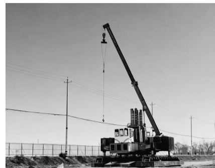
三晋健康产业项目建设现场 受访者提供
