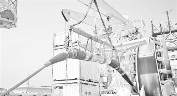
海底光缆通信系统核心装备中继器工程施工现场 ■ 受访单位供图
