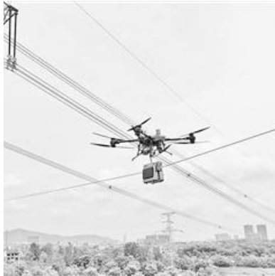
机器人通过无人机挂载对线路进行修复 ■ 翁忻旸摄
