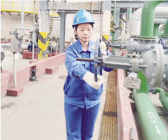
张静静在车间脱硫现场对初冷器阀门进行调节
