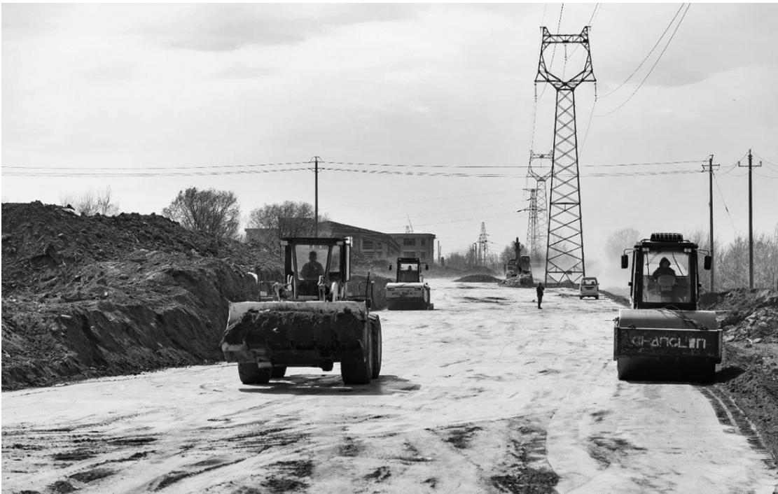
襄垣经开区基础设施建设工程——百华道路工程施工现场。 ■ 襄垣经开区供图
