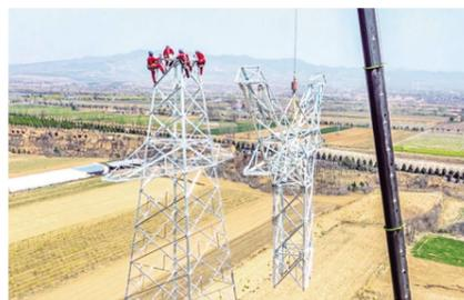
4月3日，国网山西省电力运城供电公司组织施工人员在运城市平陆县张店镇开展组塔作业。平陆—夏县220千伏线路折单长度83.98千米，新建铁塔146基，途径平陆、夏县两个县5个乡镇。工程跨越中条山，采用两条单回路设计提高线路抗大风及覆冰能力，提升电网可靠性。
