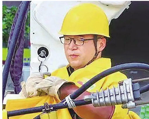
黄鑫专注城市配网检修
