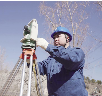
① 孙利聪攀爬上电力设施排除隐患
