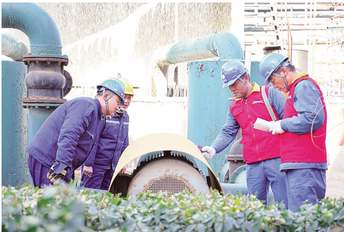
2月7日,国网夏县供电公司员工到夏县运力化工有限公司走访,开展配电设备红外测温,排查用电隐患。■ 李卓庭摄
