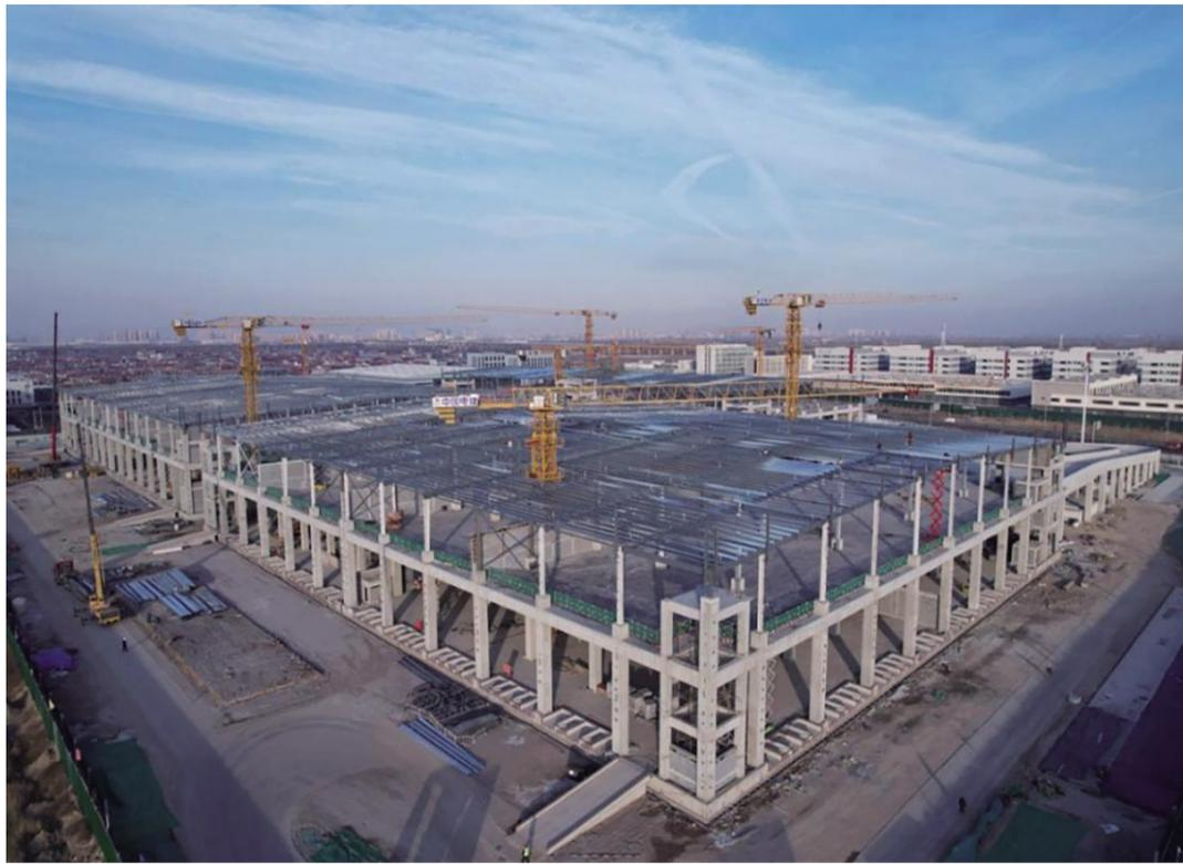
科学导报讯 12 月 6 日,随着最后一根檩条吊装完成,深国际·太原智慧物流制造中心项目 3 栋仓库顺利封顶,为下一步金属围护结构施工奠定了坚实基础。
