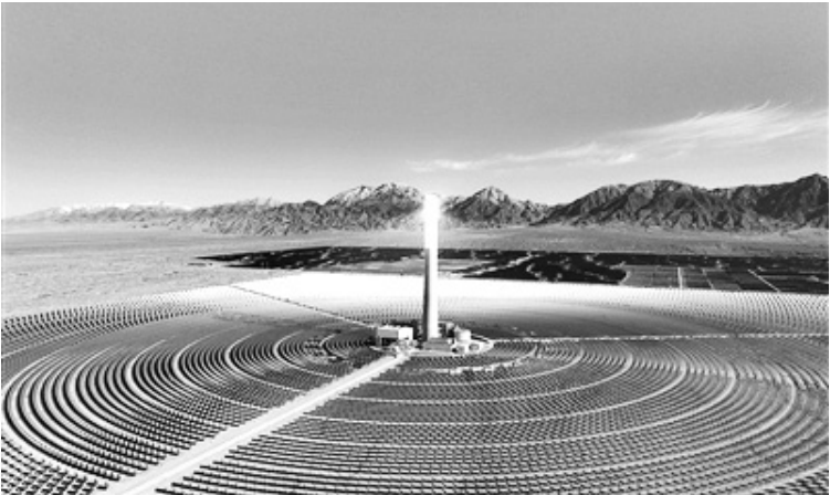
德令哈市光伏(光热)产业园的定日镜和吸热塔 ■ 张龙摄
