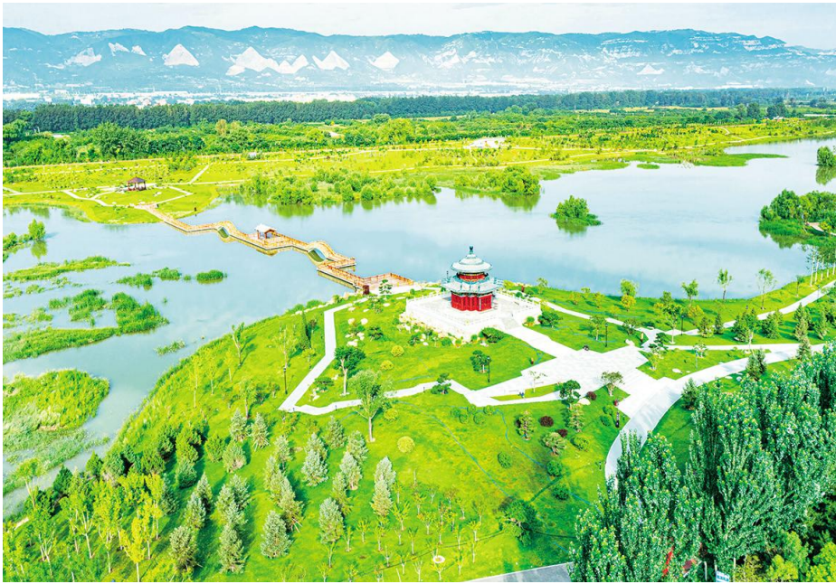
汾河生态修复治理四期工程——望岳阁
