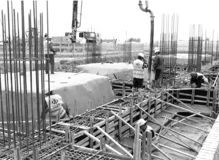
创业园区标准化厂房一期工程项目是朔州经济开发区优化营商环境，推动经济发展确定的重点建设项目，也是全省重点招商引资项目，是朔州经济开发区今年实施的重点工程之一。整个项目规划用地总面积约500亩，总建筑面积约28万平方米，项目总投资约8亿元。
