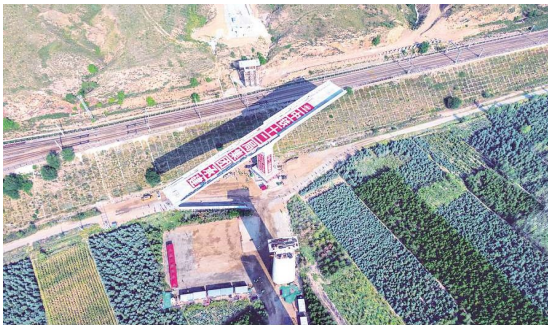
近日,在历时120分钟,逆时针旋转72度后,集大原高铁御河特大桥跨京包铁路单T构连续梁转体施工圆满完成。图为单T构连续梁正在转体。姚凡 摄
