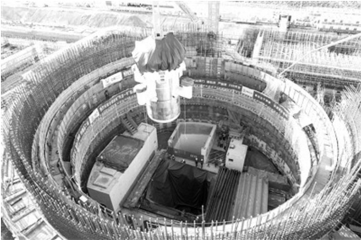
全球首个陆上模块化小型核反应堆“玲龙一号”核心模块在海南昌江吊装成功。 ■ 受访单位供图
