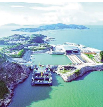
“一航津安1”号沉管运输安装一体船拖带E23管节和最终接头从珠海桂山岛起航,前往沉放水域。
