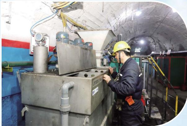
灯火通明的井下巷道,整齐划一的污水处理设备,错落有致的排水管道……在山西焦煤霍州煤电辛置矿(以下简称辛置矿)百米井下巷道里,深藏着一座占地240平方米、日处理能力达12000立方米的超磁分离污水处理站。该污水站担负着井下整个南区矿井水处理任务,于2021年7月在井下450巷道建成投用,已安全平稳运转了一年多。
